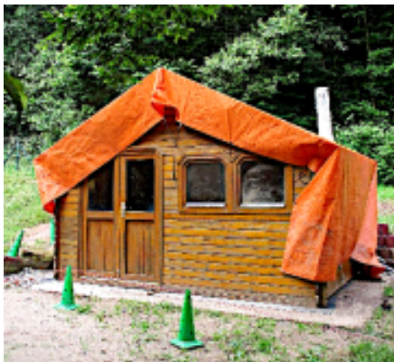
Neues Leben für altes Kassenhaus aus dem Schwimmbad Annweiler
